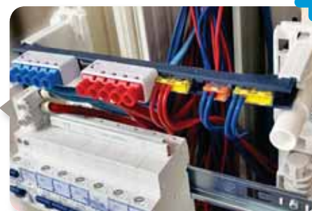
Nouveau support pour fixer des borniers Ph/N et aussi des connexions rapides EUROHM
